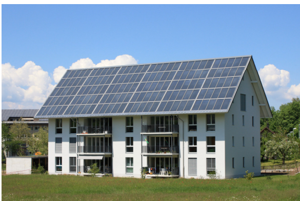
100% solar beheiztes Mehrfamilienhaus, Oberburg
